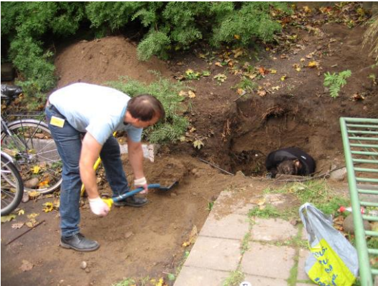
Hätäuloskäytävän luukun esiin kaivaminen.
