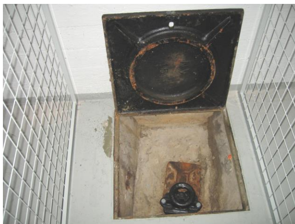
Korjattu ja huollettu viemärin sulkuventtiili.
