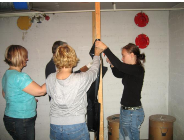
Käymälän seinien rakentaminen.
