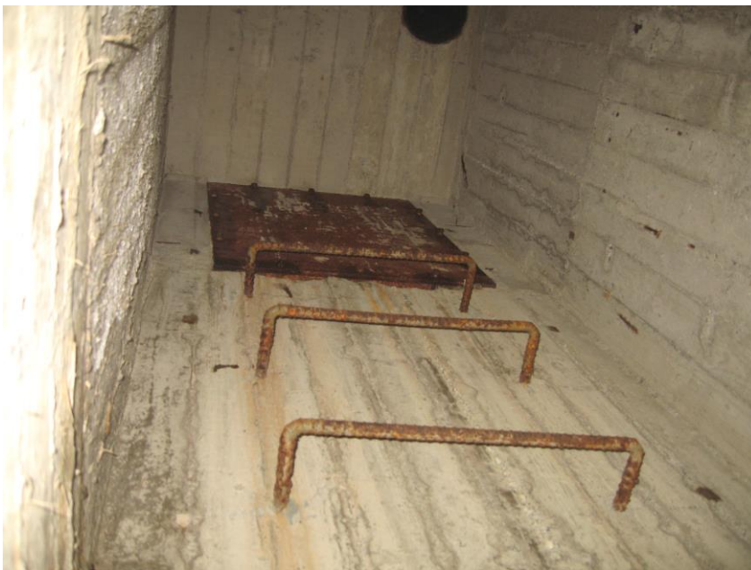
Pystykuilu (5 metriä nousua) ja pulteista irrotettava luukku.
