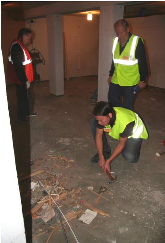
Teräsnaulojen poisto lattiasta.
