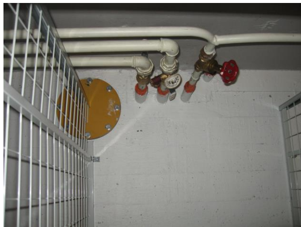
Läpivientien tiivistys teipillä.
