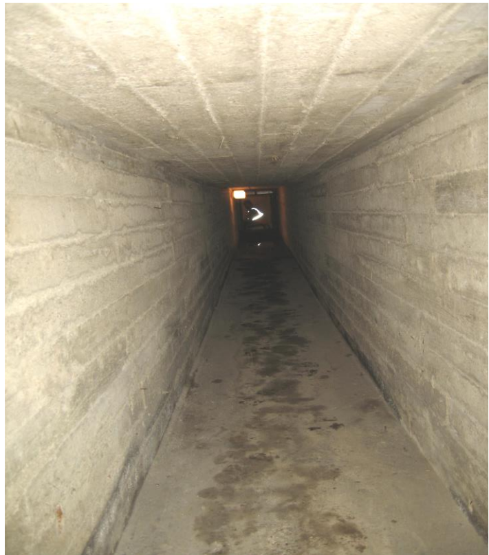
Hätäpoistumiskäytävä on 10 metriä pitkä.
