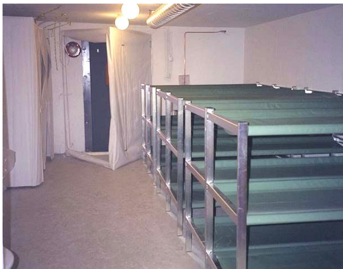
Väestönsuojaan hankitut kolmikerroksiset sängyt.
