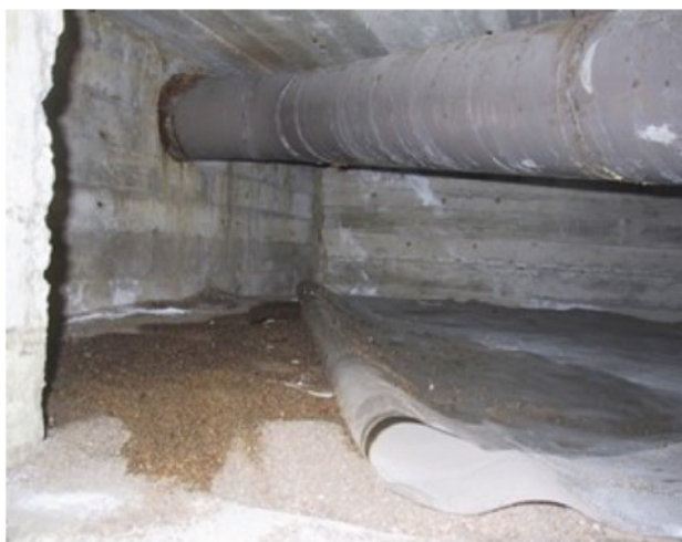
Kuva 88 ja 89. Hiekkasuodatin.
