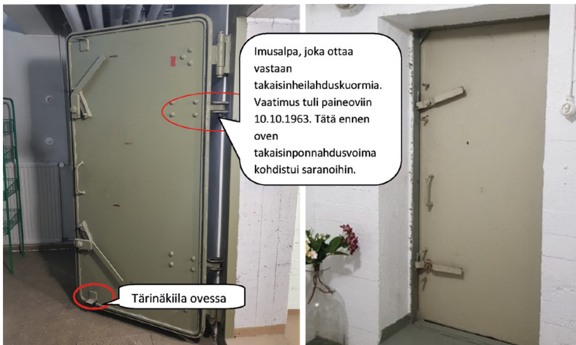
Kuva 19 ja 20. C-luokan väestönsuojan paineovi 1964–1972.
