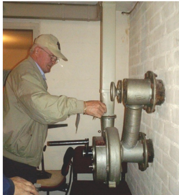
Kuvat 6 ja 7. Pelkästään käsikäyttöiset ilmanvaihtolaitteistot, jotka ottavat ulkoilmaa hiekkasuodattimen kautta.
