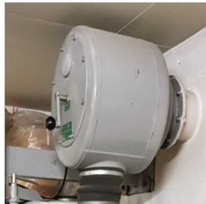
Kuvat 77–79. Paineventtiilin on täytynyt olla auki-asennossa, koska sinne on kertynyt paljon roskaa.
