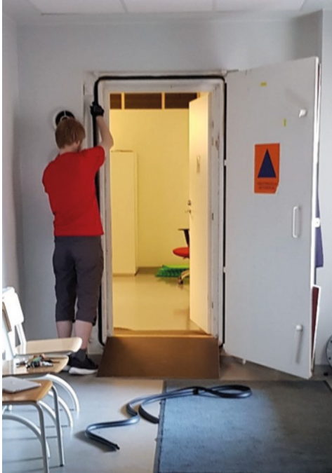
Kuva 162 ja 163. Tiivisteen vaihto sujui jouhevasti, oven kiinni laittaminen vaatii voimaa.
