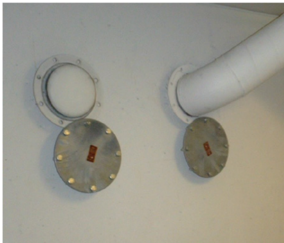
Kuva 59. Normaaliolojen ilmanvaihdon läpivienti.
