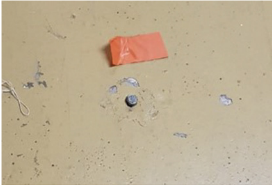
Kuva 44. Kolmiomaisen sulkuteltan lattian kiinnityspultti.
