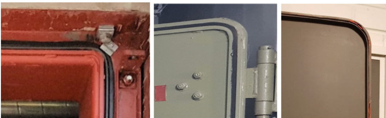
Kuvat 21–23. S1-luokan oven tiiviste oven karmissa, C-luokan 1964–1971 ovilevyssä ja C-luokan 1959–1963 ovilevyssä.
