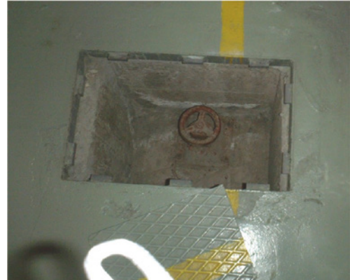
> Kuva 51. Hyvässä kunnossa oleva viemärin sulkuventtiili
