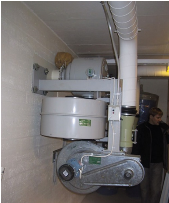
Kuva 97 ja 98. Kaksi S1-luokan ilmanvaihtolaitetta.
