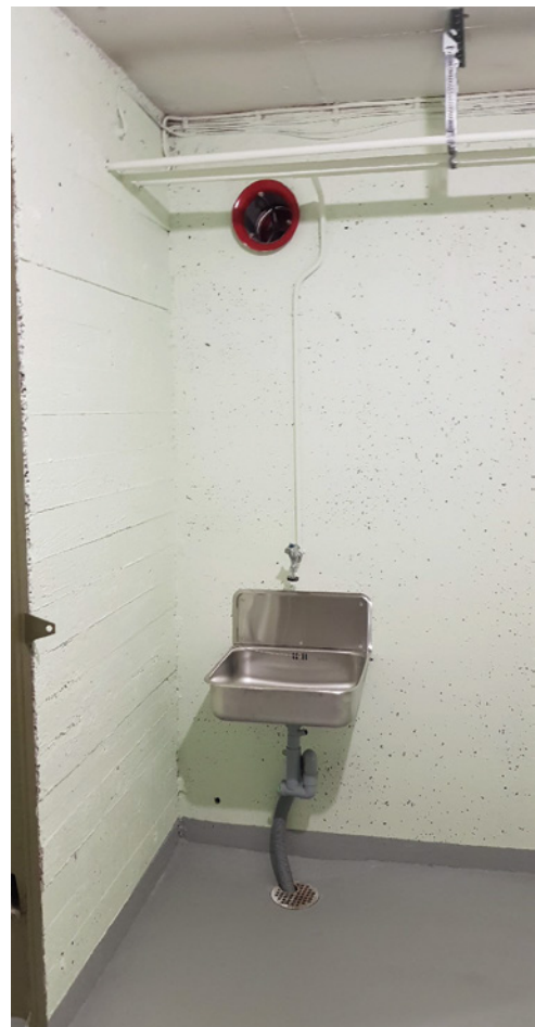
Kuva 39. Sulkuhuoneen vesipiste ja lavuaari.
