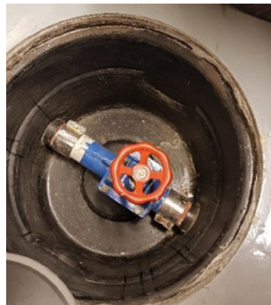
Kuva 53 ja 54. Viemärin sulkuventtiilin kaivossa on usein kosteutta ja jopa vettä, mutta se toimii silti.
