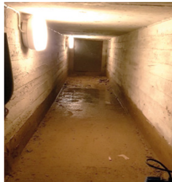
Kuva 102 ja 103. Hätäpoistumiskäytävässä aika usein vettä.
