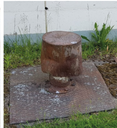
^ Kuvat 121–123. Eri ikäisten suojien ilmanottoputkia.
