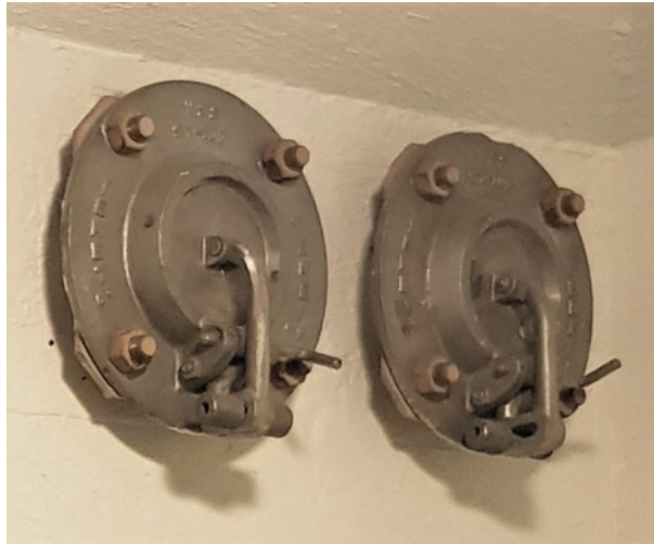
Kuva 71. C-luokan ylipaineventtiili.
