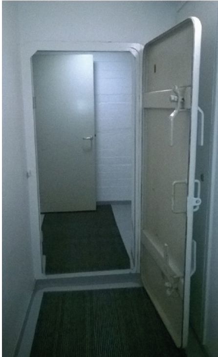
Kuva 3. Paineovi oli terästä, kaasutiivis ovi puuta.
