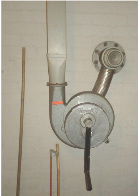
Kuva 82. Käsikäyttöinen ilmanvaihtolaite 1959–1963.
