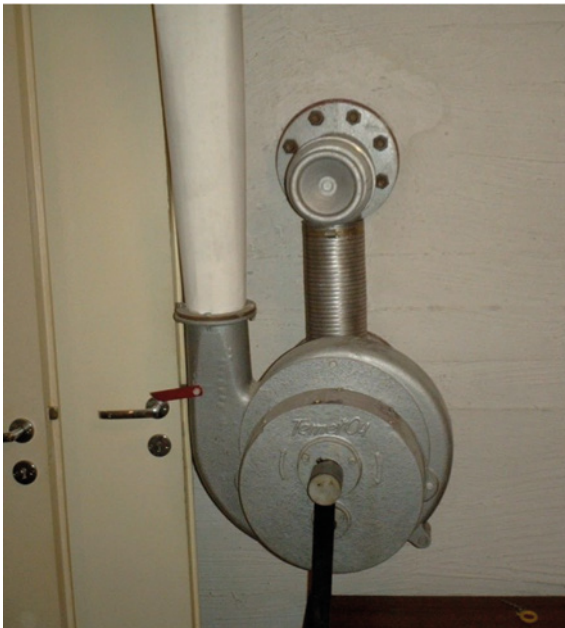
Kuvat 6 ja 7. Pelkästään käsikäyttöiset ilmanvaihtolaitteistot, jotka ottavat ulkoilmaa hiekkasuodattimen kautta.
