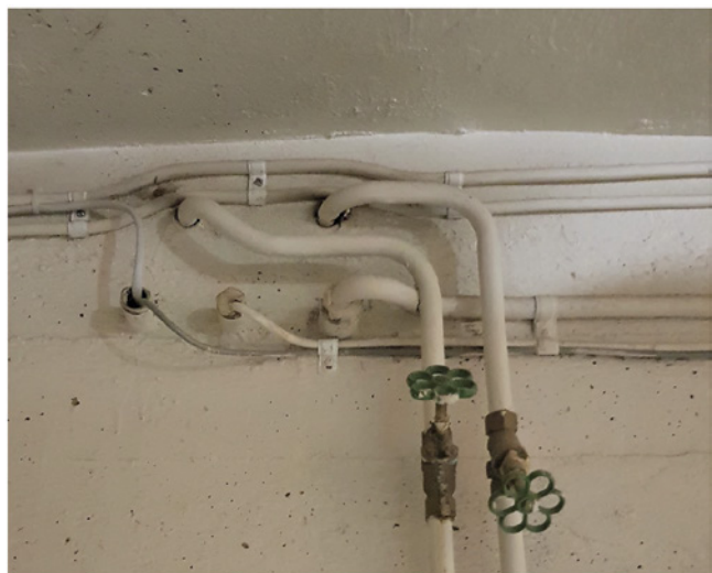
Kuva 62. Sähkö- ja putkiläpiviennit holkiputkessa.
