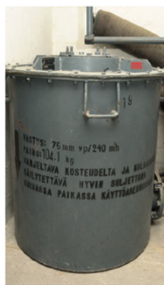
Kuvat 90–92. C-luokan hiilisuodatin ja hiekkasuodattimen kautta tuleva ulkoilma.
