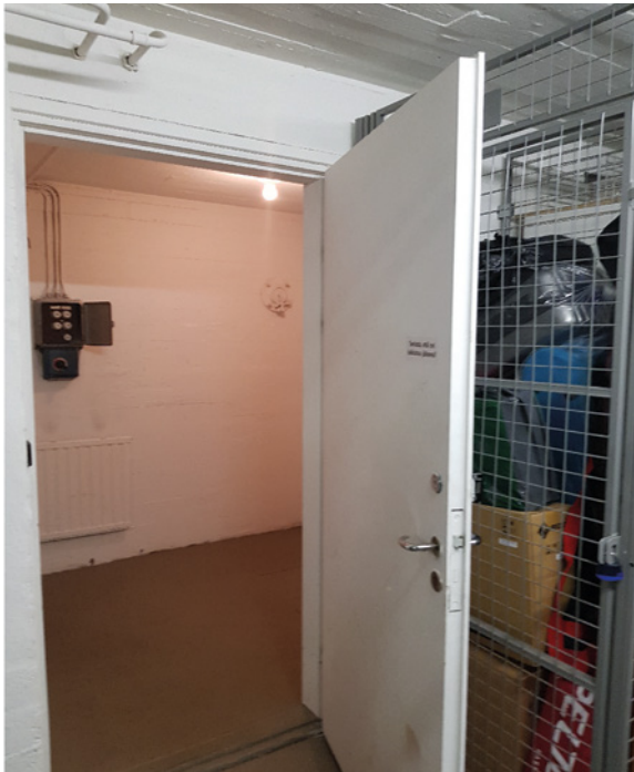
Kuva 40. C-luokan sulkuhuoneen puuovi 1959–1963.
