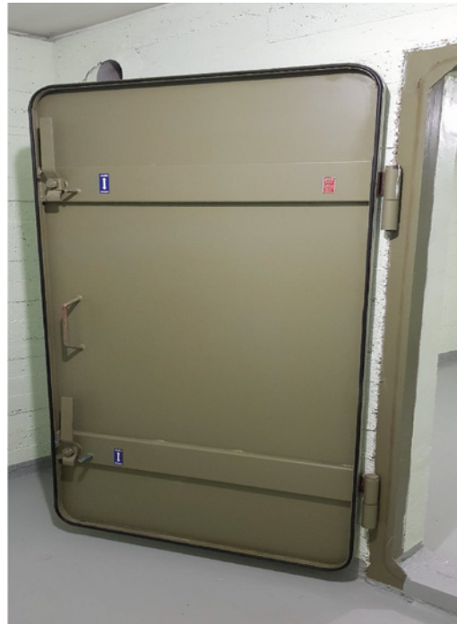
Kuva 41. C-luokan sulkuhuoneen metalliovi 1964–1972.
