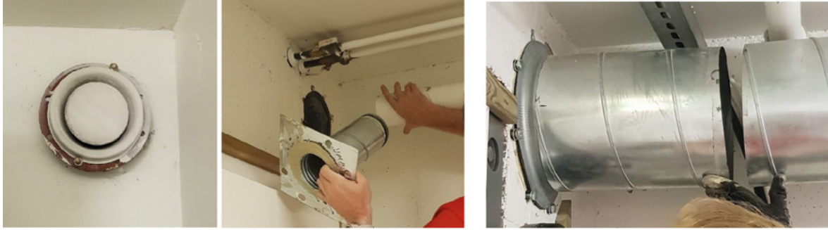
Kuvat 156–158. Keravan kaupungin omistamien kiinteistöjen normaaliolojen ilmanvaihtokanavien sulkulaippojen asennus
