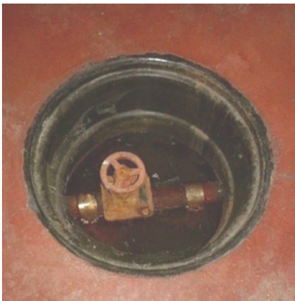
Kuva 53 ja 54. Viemärin sulkuventtiilin kaivossa on usein kosteutta ja jopa vettä, mutta se toimii silti.
