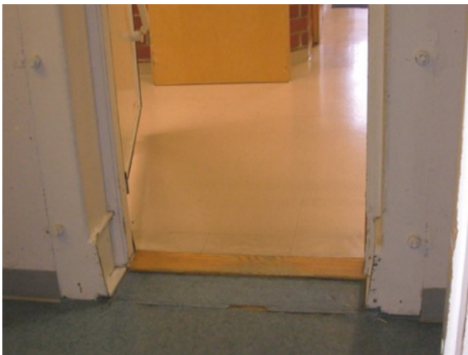
Kuva 28 ja 29. Jonkin verran on tehty irtokynnyksellisiä ovia. Kynnykset on varastoitu yleensä hätäpoistumiskäytävään.
