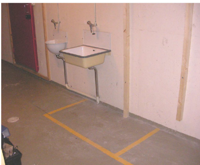
Kuva 109. Käymälän merkintä lattiaan ja kiinnitysrimat.
