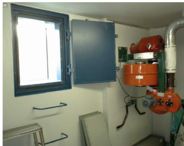
Kuva 105. Maanpäällisen suojan sirpalesuojattu luukku.
