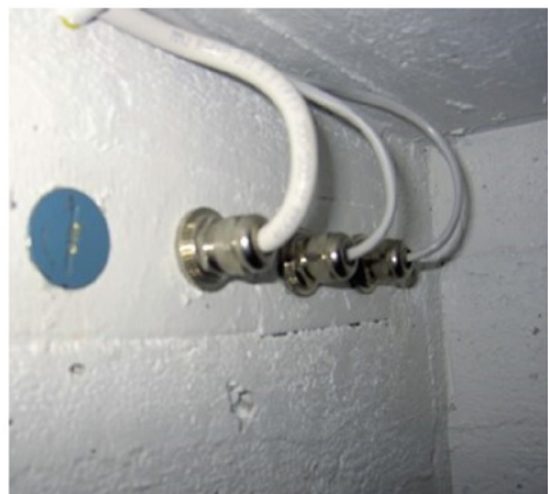
Kuva 60. Sähköläpivienti.
