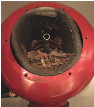
Kuvat 77–79. Paineventtiilin on täytynyt olla auki-asennossa, koska sinne on kertynyt paljon roskaa.
