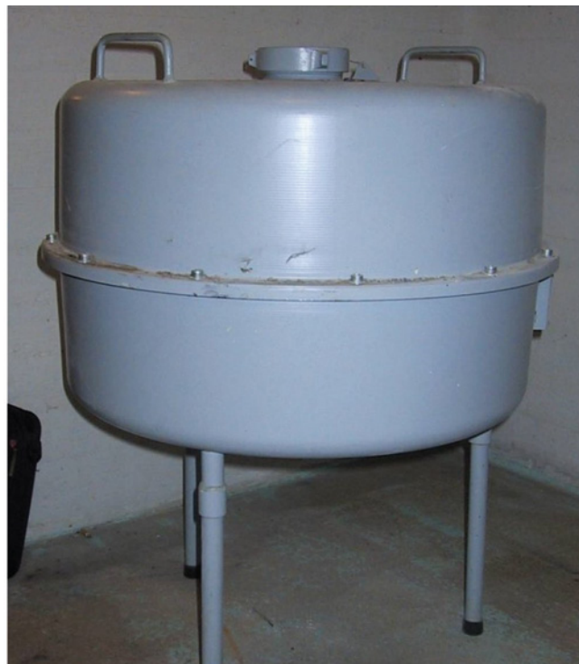
Kuva 84 ja 85. Vuosien 1964–1972 C-luokan ilmanvaihtolaitteisto ja sen hiilisuodatin, paino 85–120 kg.
