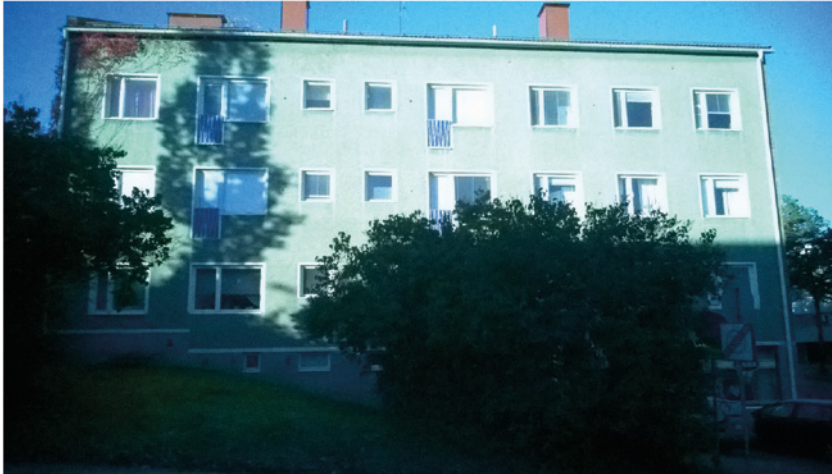
Kuva 1. Vuosina 1955–1958 rakennettuihin rakennuksiin tehtiin väestönsuojia.
