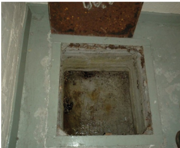
Kuva 46. C-luokan väestönsuojan kokoojakaivo.
