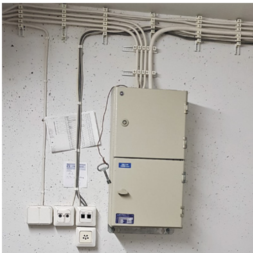
Kuva 132 ja 133. Puhelin- ja antennipistokkeet.
