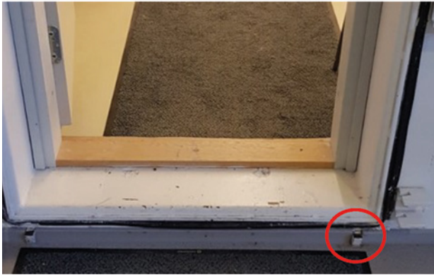
Kuva 24. S1-luokan ovissa tärinäkiila hitsattuna karmiin.
