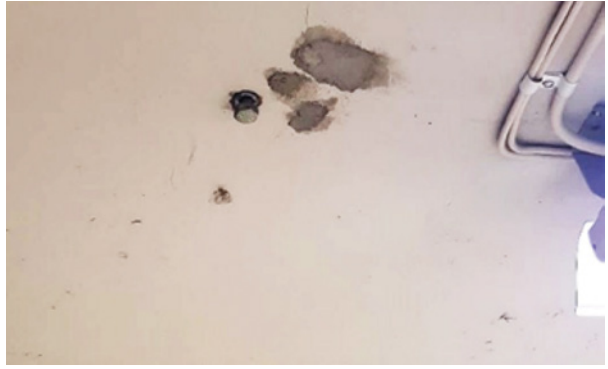
Kuva 45. Sulkuteltan katton kiinnityspultti.
