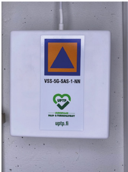
Kuva 136 ja 137. Passiiviantenni.
