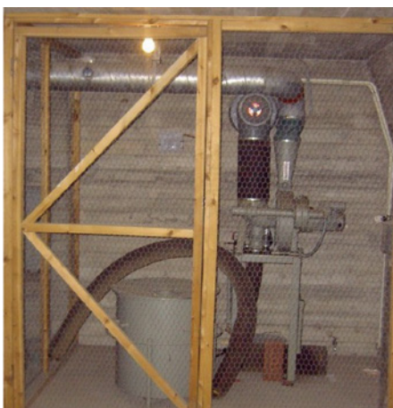
Kuvat 10–12. Sähkökäyttöinen ilmanvaihtolaite ja siihen liitettävä hiilisuodatin hiekkasuodattimen lisäksi.
