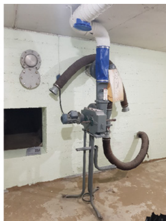
Kuvat 10–12. Sähkökäyttöinen ilmanvaihtolaite ja siihen liitettävä hiilisuodatin hiekkasuodattimen lisäksi.
