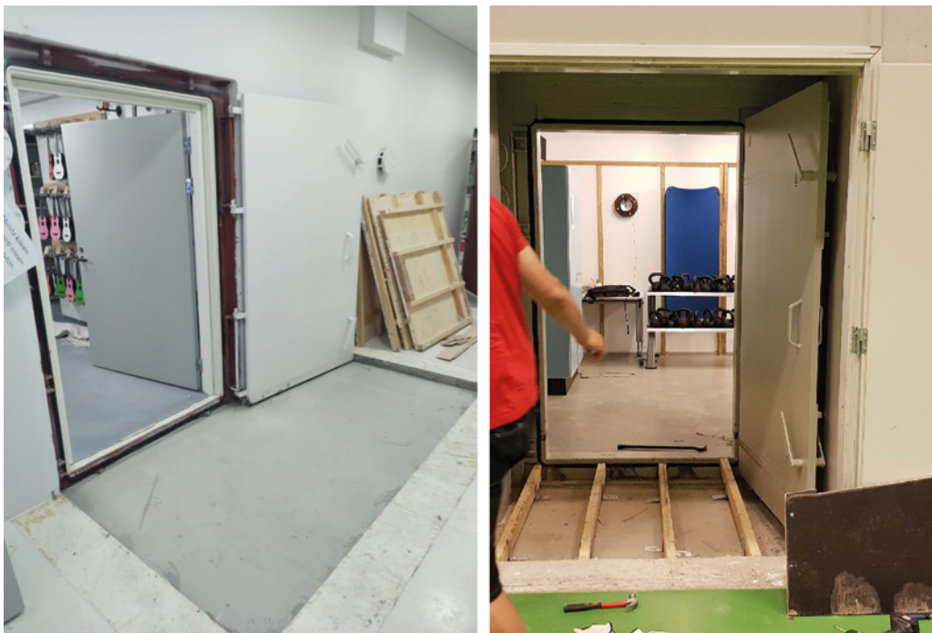
Kuva 147 ja 148. Oven edustan purkaminen tiiveyskoetta varten.
