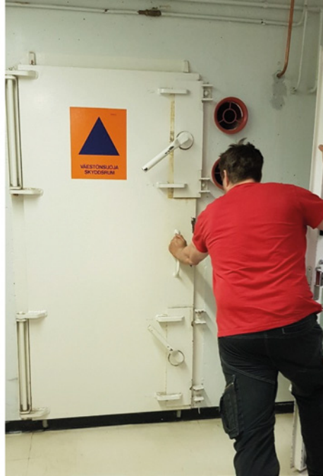
Kuva 162 ja 163. Tiivisteen vaihto sujui jouhevasti, oven kiinni laittaminen vaatii voimaa.
