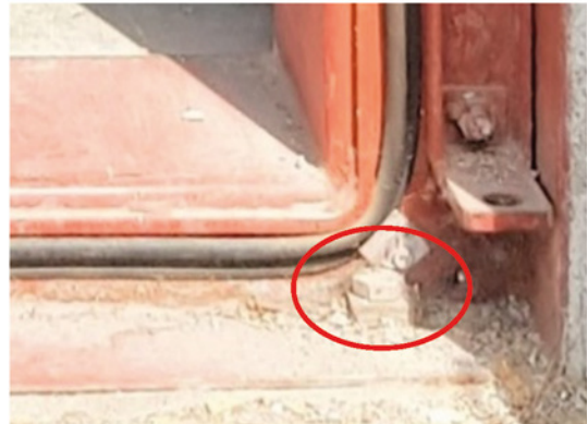
Kuva 25. S1-luokassa tärinäkiilana pultti, joka on säädettävissä.
