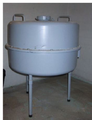
Kuvat 10–12. Sähkökäyttöinen ilmanvaihtolaite ja siihen liitettävä hiilisuodatin hiekkasuodattimen lisäksi.
