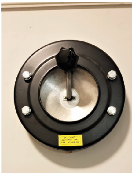
Kuva 72. S1-luokan ylipaineventtiili.
