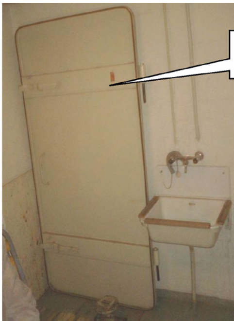
Kuva 26. C-luokan paineovi 1959–1963 sulkuhuoneessa.
