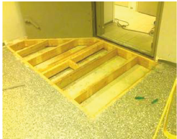
Kuva 27. Lattia on voitu rakentaa kynnyksen kanssa samaan.
