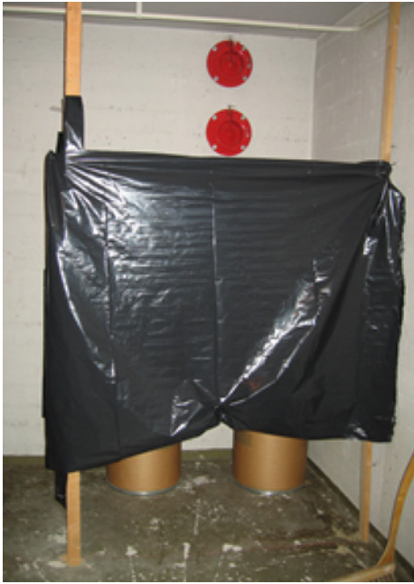
Kuva 111. Hätäratkaisu käymälän rakentamisessa.
