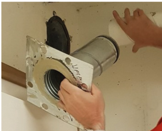
Kuvat 65–67. Normaaliolojen ilmanvaihdon läpivienti.
