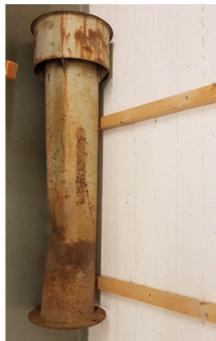
^ Kuvat 121–123. Eri ikäisten suojien ilmanottoputkia.
