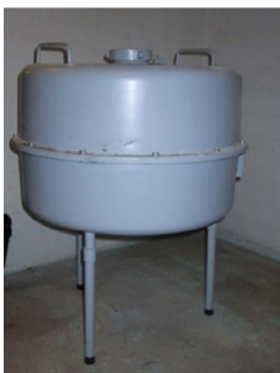
Kuvat 90–92. C-luokan hiilisuodatin ja hiekkasuodattimen kautta tuleva ulkoilma.
