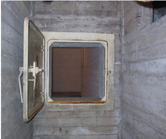
Kuva 30 ja 31. Hätäpoistumiskäytävän luukku aukesi käytävään päin vuoteen 1991 saakka. Luukku aukeaa sisäänpäin.
