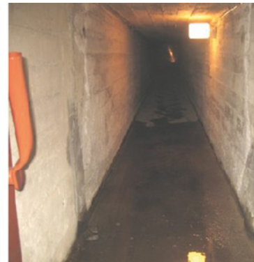
Kuva 102 ja 103. Hätäpoistumiskäytävässä aika usein vettä.
