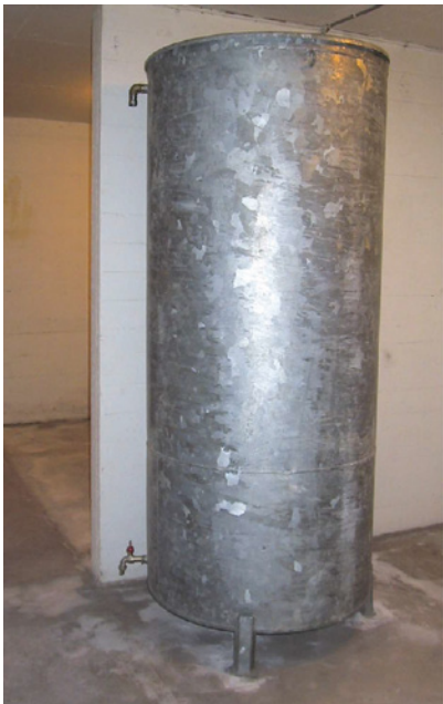
Kuva 116. Sinkitty 60-luvun vesisäiliö.
