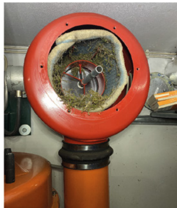
Kuvat 77–79. Paineventtiilin on täytynyt olla auki-asennossa, koska sinne on kertynyt paljon roskaa.
