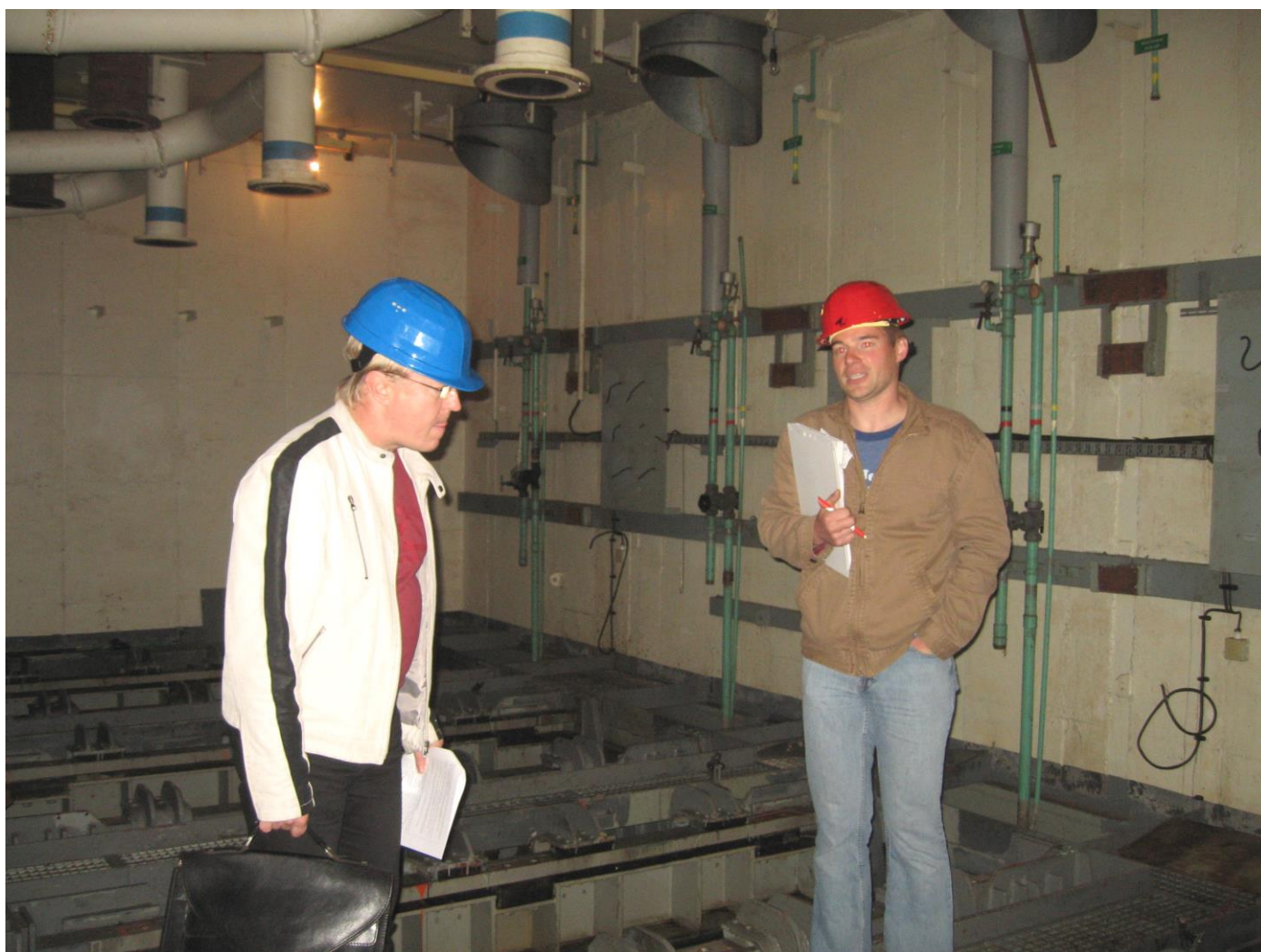
Konehuoneesta oli purettu kaikki 5 varavoimakoneet
