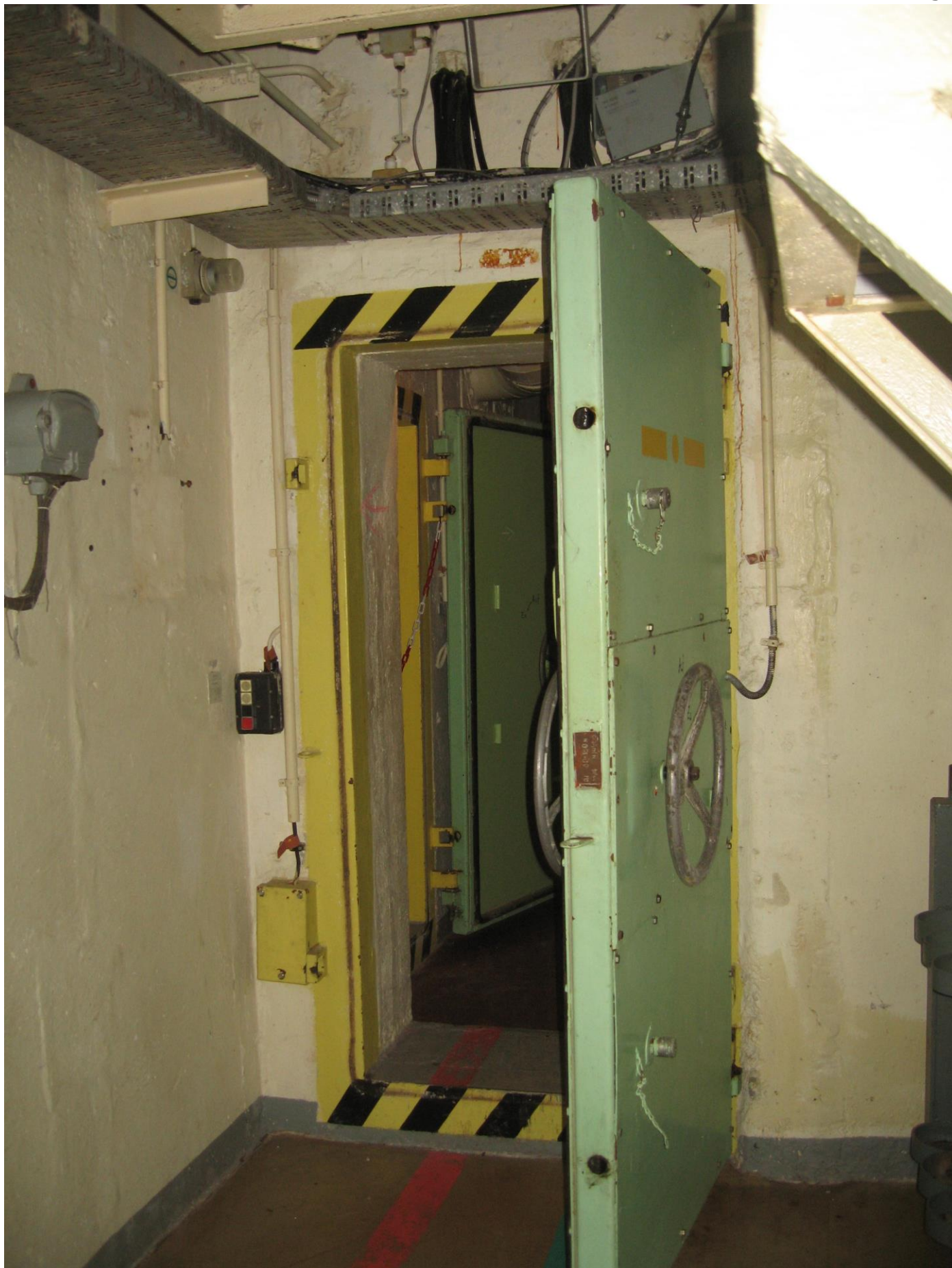
Kaasutiiviissä ovesa oli kumitiivisteet erikoisuutena paineentasausventtiili.
